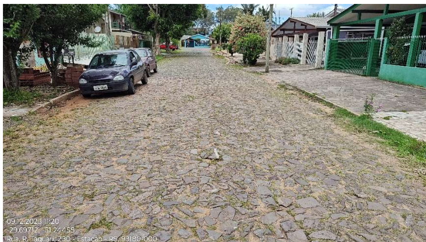
Foto 23 – Sequência do estaqueamento (foto georreferenciada)
