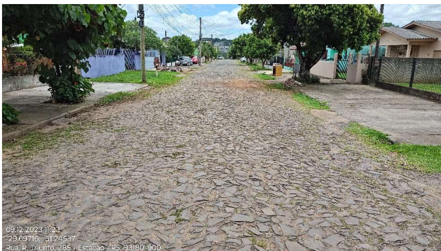
Foto 29 – Sequência do estaqueamento (foto georreferenciada)
