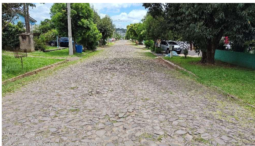
Foto 28 – Sequência do estaqueamento (foto georreferenciada)
