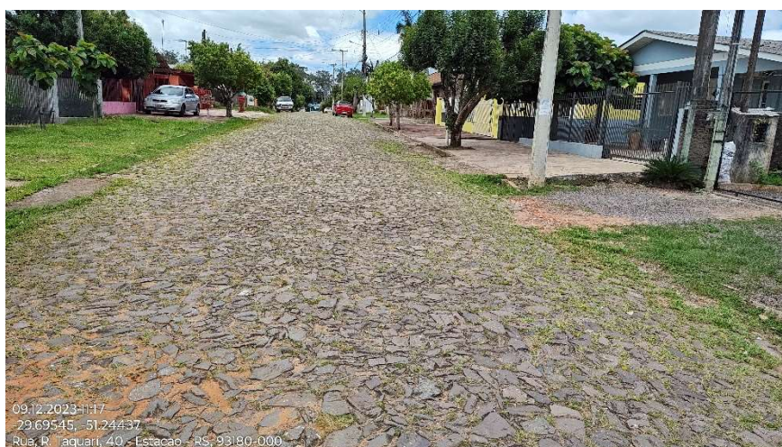
Foto 16 – Sequência do estaqueamento (foto georreferenciada)
