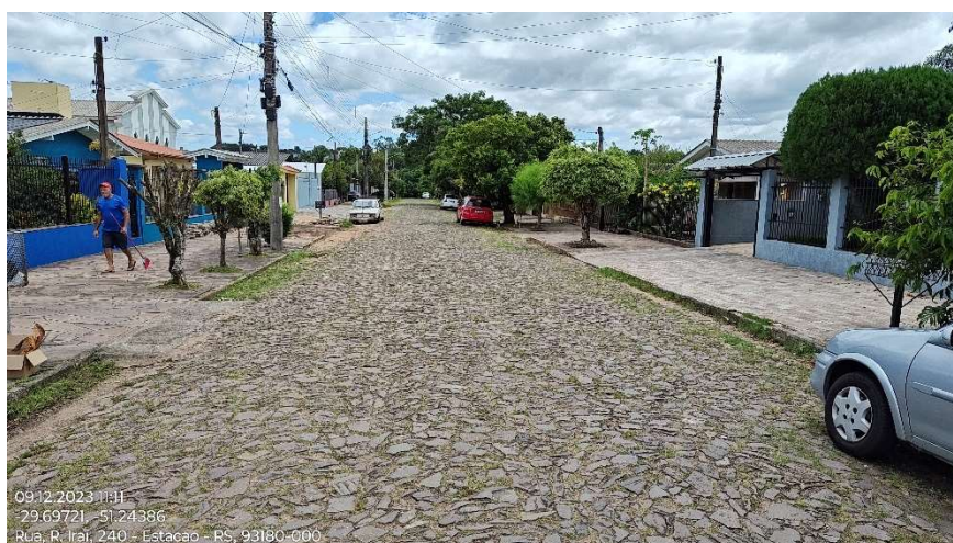
Foto 5 – Sequência do estaqueamento (foto georreferenciada)
