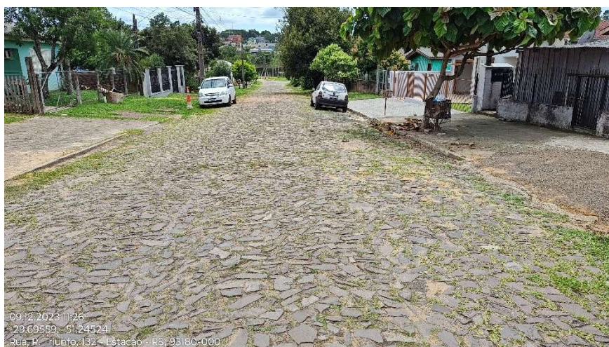
Foto 36 – Sequência do estaqueamento (foto georreferenciada)
