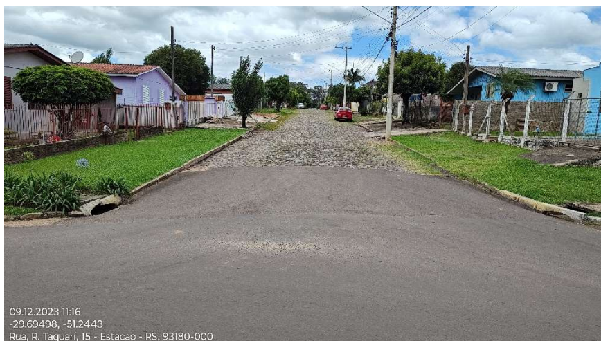
Foto 14 – Fim do trecho e concordância com Rua Rio Pardo (foto georreferenciada)
