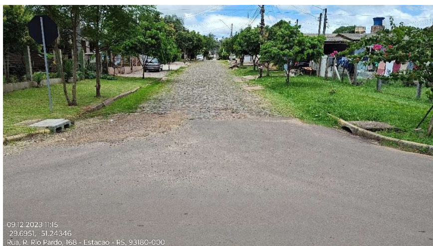
Foto 13 – Fim do trecho e concordância com Rua Rio Pardo (foto georreferenciada)
