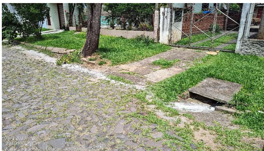
Foto 18 – Sequência do estaqueamento (foto georreferenciada)
