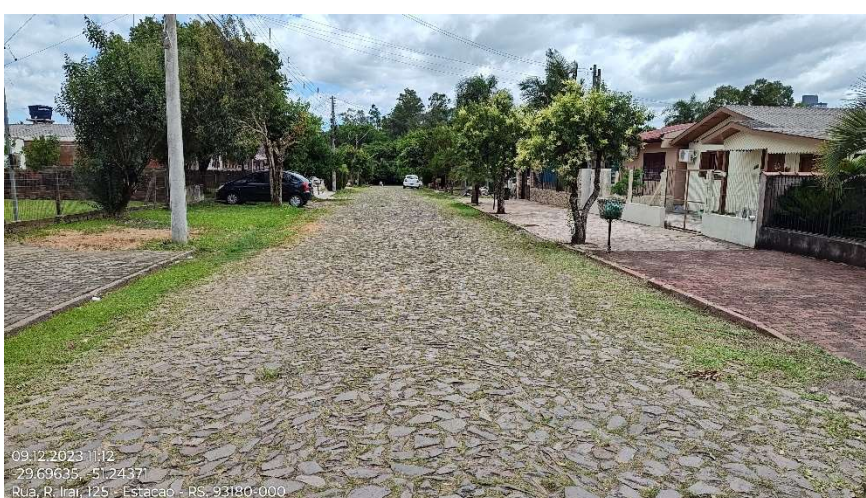
Foto 8 – Sequência do estaqueamento (foto georreferenciada)
