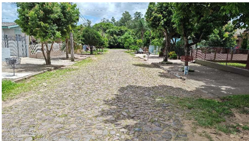
Foto 12 – Sequência do estaqueamento (foto georreferenciada)
