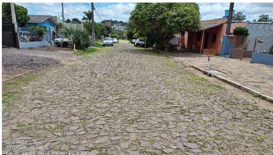
Foto 35 – Sequência do estaqueamento (foto georreferenciada)
