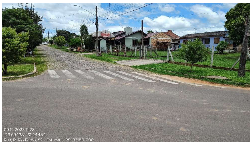
Foto 39 – Fim do trecho e concordância com Rua Rio Pardo (foto georreferenciada)
