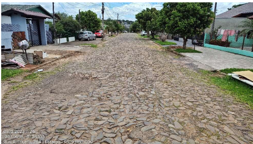
Foto 30 – Sequência do estaqueamento (foto georreferenciada)
